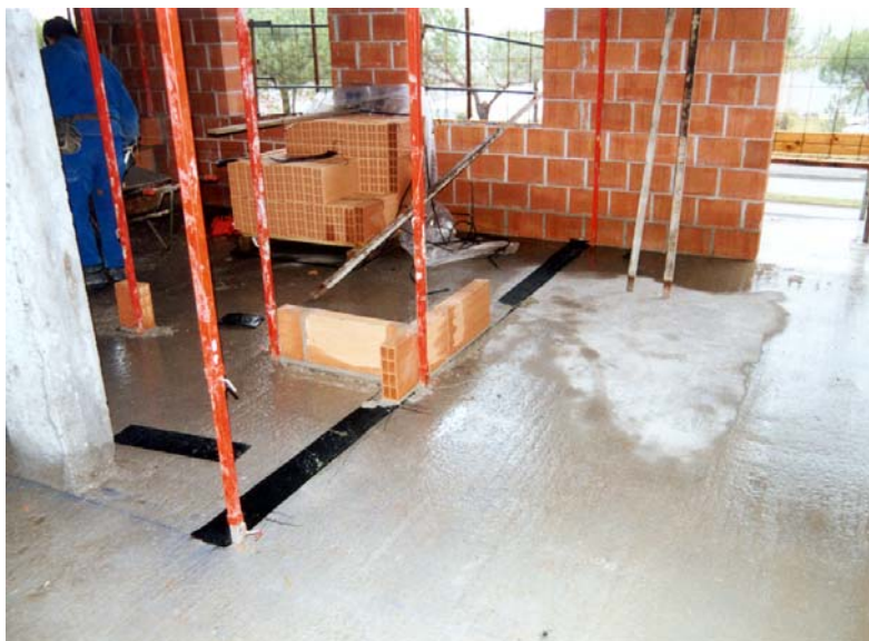
ESECUZIONE DI MURI DIVISORI INTERNI SU STRISCIA DI GOMMA
